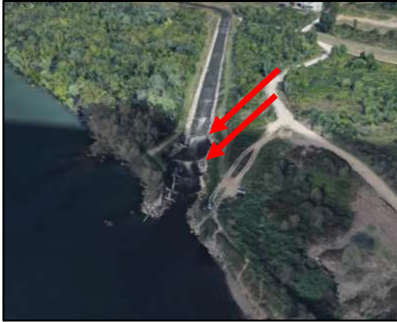
Slika 4.3-2. Hidrotehničke stepenice izvedene na koritu GOK-a (neposredno prije ušća u Savu) oko 3.115 m nizvodno od lokacije zahvata (izvor: Google Earth, 2020.)
