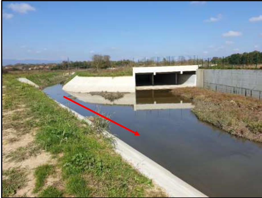
Slika 2.1-6. Uljev transportnog kolektora Sesvete neposredno nizvodno od početka predmetne dionice, s označenim smjerom tečenja (izvor: Viacon, 2019.)
