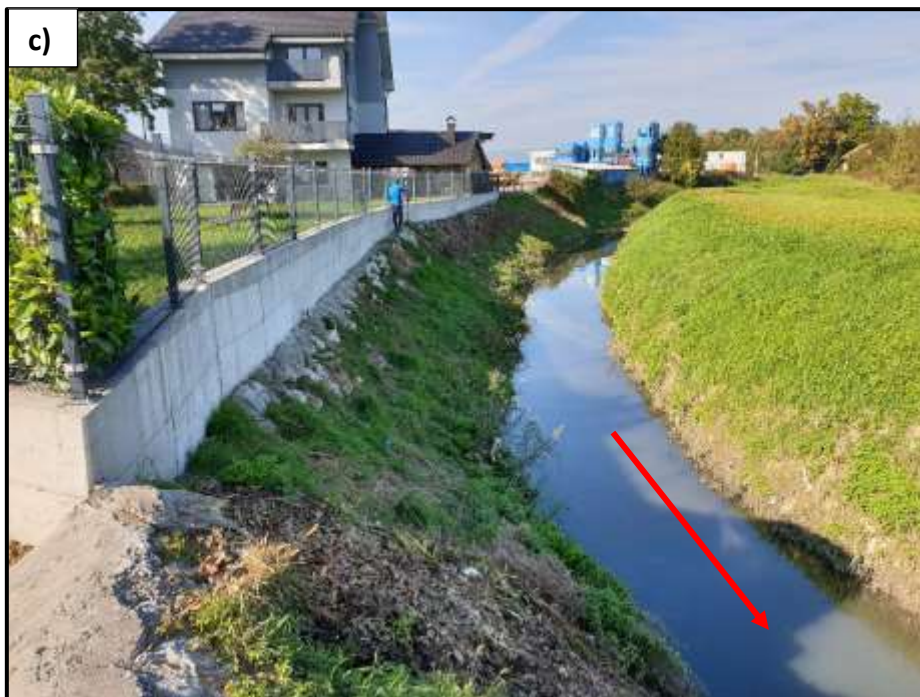
Slika 2.1-3. Dionica potoka Vuger nizvodno od mosta u stac. km 1+403,00, s označenim smjerom tečenja: a) obraslo korito i nanosi u koritu neposredno nizvodno od mosta, b) grmljem obrasla desna obala potoka Vuger uz ograđene privatne parcele uzvodno od stac. km 1+340,00, c) postojeći AB parapetni zidovi na dionici stac. km 1+190 do km 1+340,00 (izvor: Viacon, 2019. )
